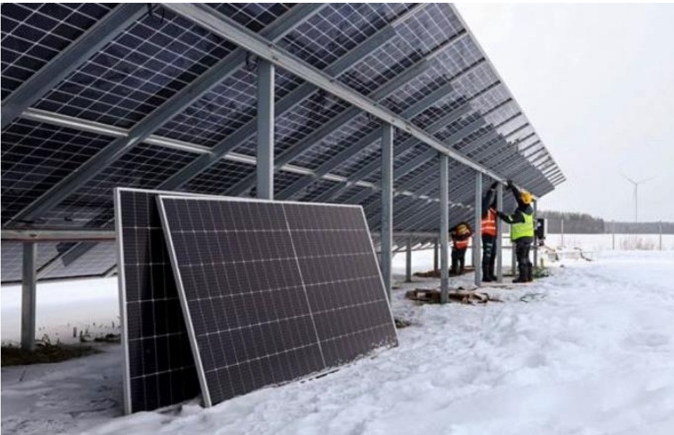
Kuva 6. Paneelit asennetaan 30 asteen kulmaan (kuva Helsingin Sanomat)
